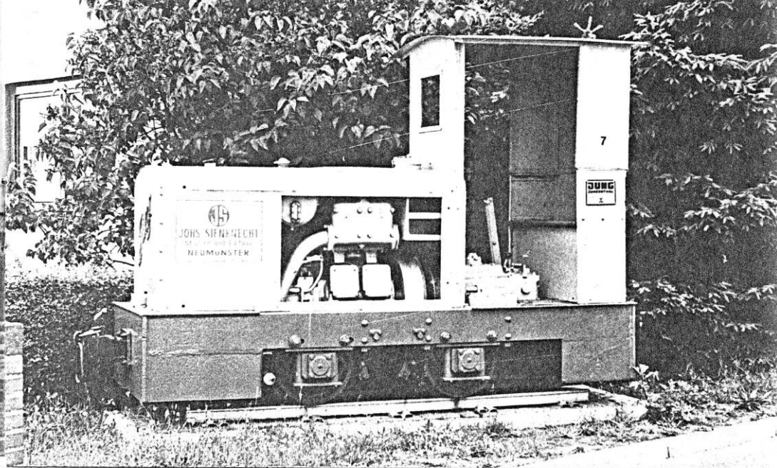
An der Einfahrt zur Bauunternehmung Johs. Sienknecht in Neumünster erinnert die als Denkmal aufgestellte Lok 7 an vergangene Zeiten! Die Aufnahme zeigt sie am 25. Juni 1982 Foto: Ulrich Völz
