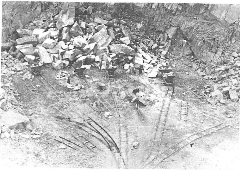
Steinbruch Theisbergstegen: Blick in den Steinbruch, wo die einzelnen Loren zur Beladung auf eine Gleisharfe verteilt worden sind (1956, R. Kühne).
