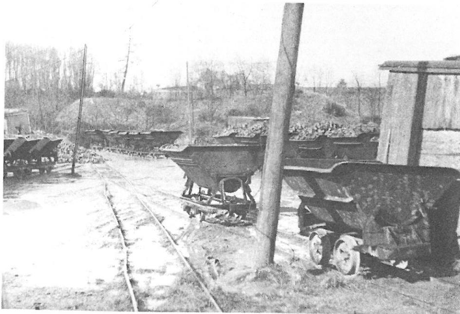
Das Rohmaterial wurde in Rollwagen geladen und in Zügen mit einer Diesellok zum Vorbrecher am Rande der Abbaustufe gebracht. Material zur Pflastersteinherstellung wurde über einen Bremsberg zum Abrichterplatz gefahren. Das Schottermaterial kam vom Vorbrecher zum Hauptbrecher mittels einer Seilzugstrecke (Bremsberg). Dort wurde es zu den Endprodukten verarbeitet. Zum Theisbergstegener Bruch gehörten auch die Haschbacher Brüche, die ähnlich arbeiteten, heute aber stillgelegt sind.
