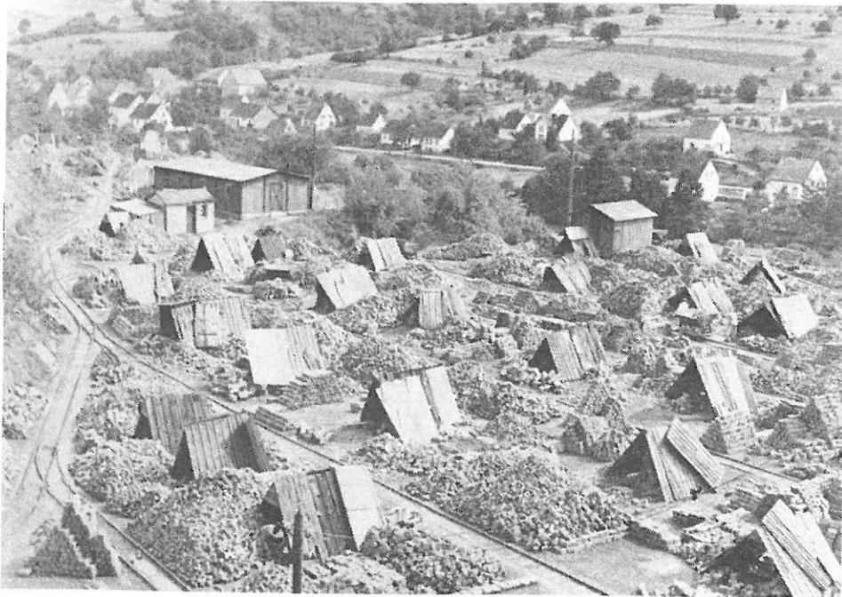
Steinbruch Theisbergstegen; Blick auf den Abrichterplatz im Jahre 1956. Deutlich erkennbar sind die Hütten der Abrichter und die dazwischen verlegten Feldbahngleise (1956, R. Kühne). Die untere Aufnahme zeigt einen für vier Wagen vorgesehenen Bremsberg. Das Gegengewicht läuft auf dem inneren Schienenpaar und ist knapp über dem Lorengestell zu sehen (1956, R. Kühne).
