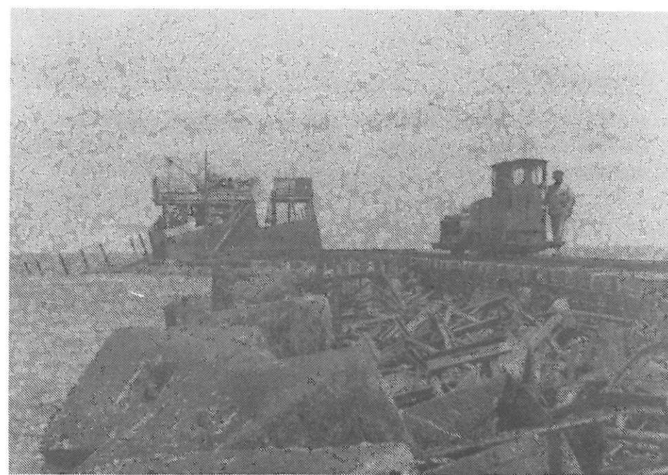
Minsener Oog: Die historischen Fotos zeigen die kleinere der beiden Verbrennungsloks vor dem Senkkasten am Kopfende der Buhne A (oben, 28.08.1929) und noch einmal beide Verbrennungsloks vor einem Lorenzug (unten, 14.05.1930).
