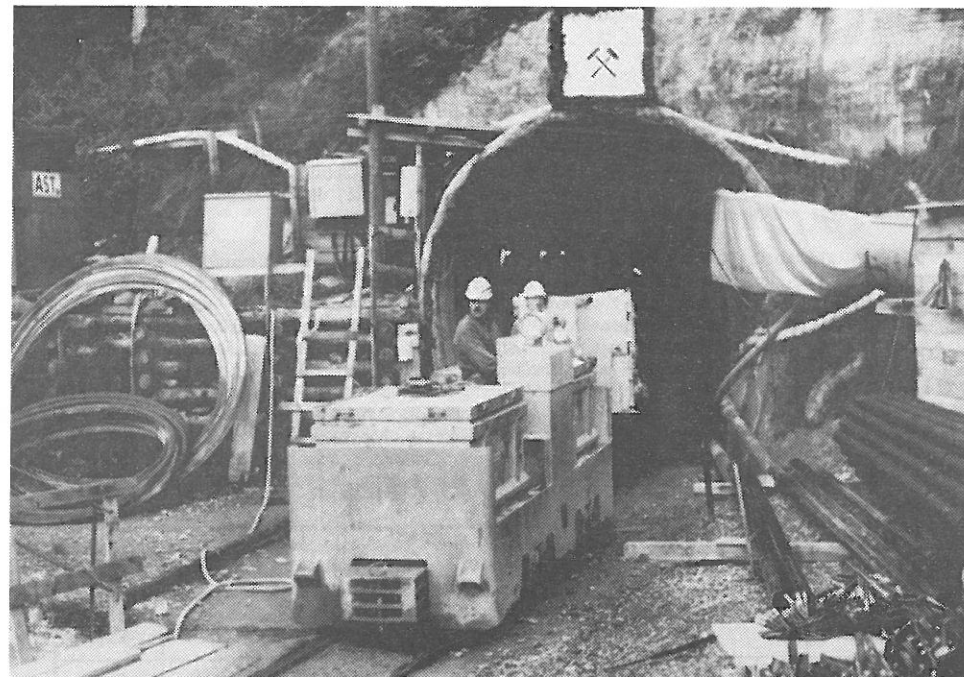
Triebwasserwerk Gerlos: Das obere Foto zeigt die SIG-Lok, wie sie gerade den Elisabeth-Stollen verläßt. Das untere Foto entstand einige hundert Meter höher vor dem Regine-Stollen und zeigt die erst tags zuvor hier eingetroffene Schöma 4824, dahinter die Schöma 4800 (06.09.89).
