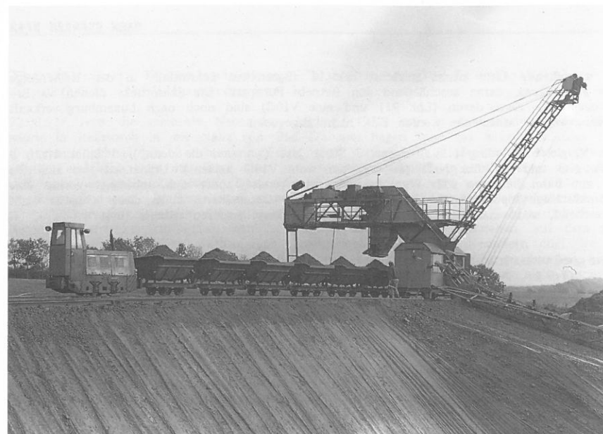
Ziegelwerk Möllenhagen: Zu kurzfristigem Leben erwachten das Ziegelwerk und die Bahn im Oktober 1992 - hier eine Unio-Lok mit Zug, aufgenommen an einem Samstagnachmittag (17.10.92).
