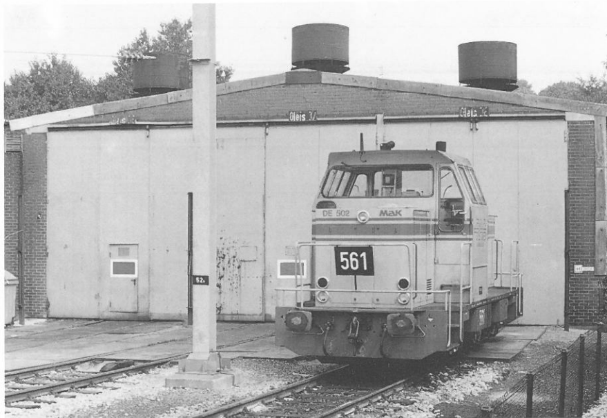
Ruhrkohle AG: Lok 561 steht vor dem Lokschuppen der Zentralwerkstatt in Gladbeck (22.08.92, Burkhard Beyer).
