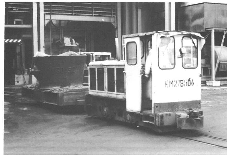
Norddeutsche Affinerie, Hamburg: Restbetrieb auf der Schmalspurbahn, EM 278 504 (Schöma 3233) ist mit einem Flüssigkupertransport unterwegs. Unten ist die EM 245 503 (Jung 14130), die auf den Normalspurgleisanlagen ihren Dienst versieht, zu sehen (21.11.94).
